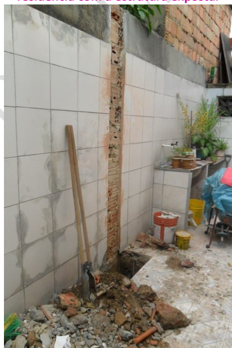
Figura 11: Reconstrução e tratamento do pilar da área de serviço da residência com a estrutura exposta.
