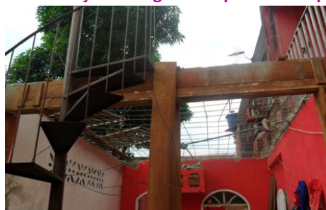
Figura 10: Reconstrução da viga e dos pilares comprometidos.
