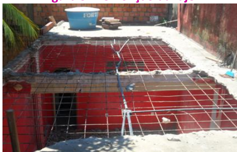
Figura 9: Demolição da laje.
