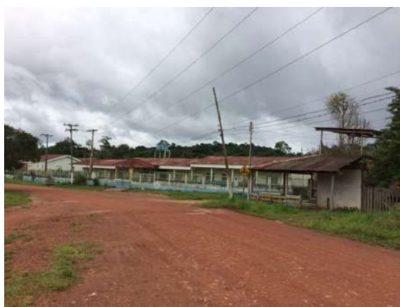
Figura 2 – Infraestrutura das ruas assentamento de Canoas
