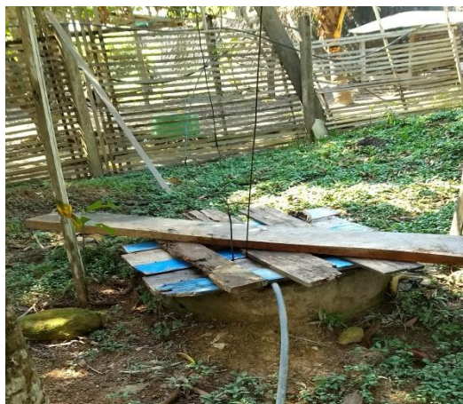
Figura 5C– Cacimba em terreno acive e tampa inadequada – Vila Canoas
