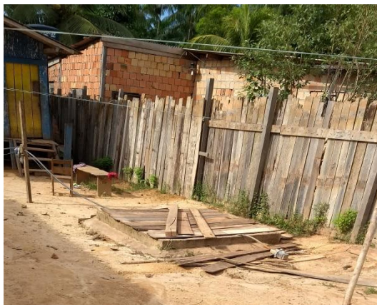
Figura 5A – Cacimba com borda e tampa inadequada – Vila Canoas Fonte: José Edson Lima da Silva- 2017
