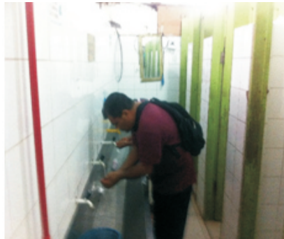
Figura 09. Condições banheiro masculino. Fonte: O Autor.
