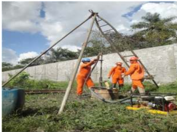
Figura 4: Execução da sondagem à percussão SPT. Fonte: Franco engenharia, (2016).
