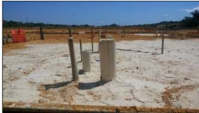
Figura 8: Envelopamento e nivelamento da superfície com areia. Fonte: Os Autores, (2017).
