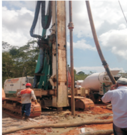
Figura 11: Injeção da argamassa. Fonte: Elaborado pelos autores, (2015).
