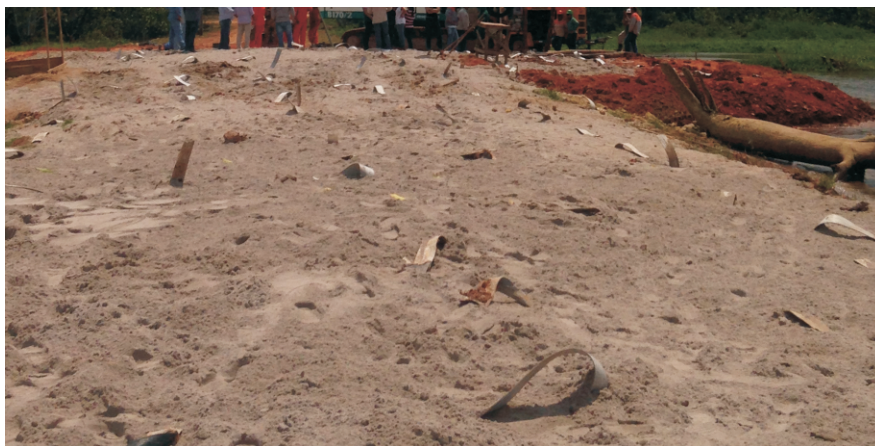
Figura 4: Geodrenos pré-fabricados. Fonte: Autores, (2015)
