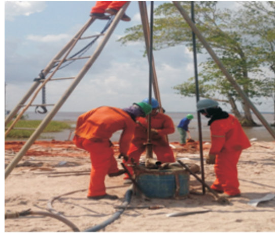
Figura 14: Sondagem SPT. Fonte: Autores, (2015).
