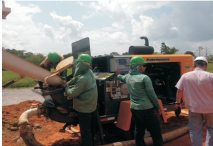
Figura 5: Bombeamento do composto grout. Fonte: Autores, (2015)
