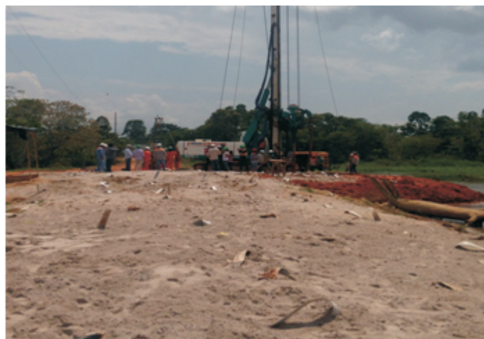
Figura 10: Instalação de Geodrenos. Fonte: Autores, (2015).
