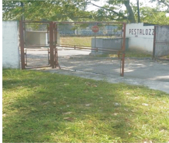
Foto 2: Entrada de acesso a escola. Fonte: Próprio autor.
