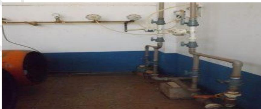
**Figura 10: Sistema de cloração**
